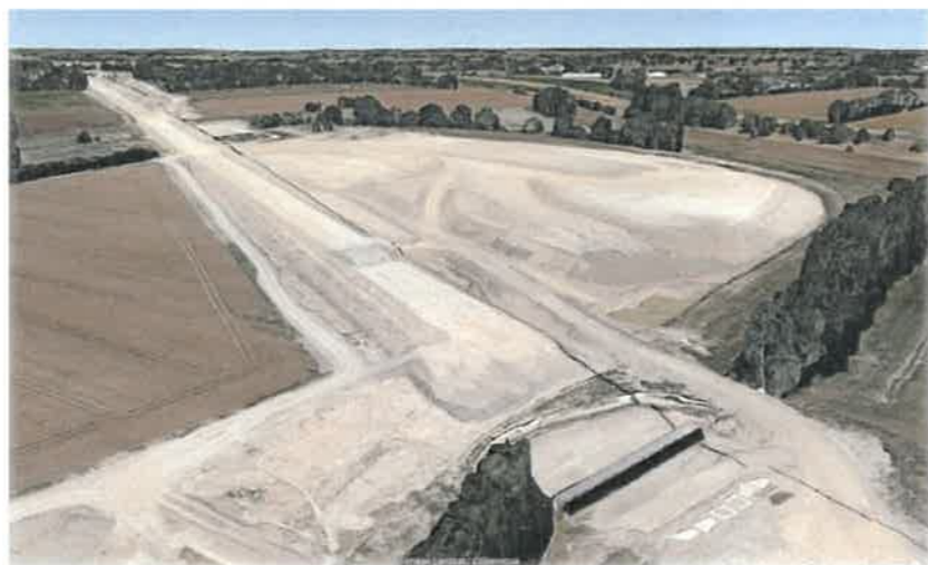
Figure 1 : Vue aérienne oblique du site projet en phase de travaux de la LGV (Google Earth)
